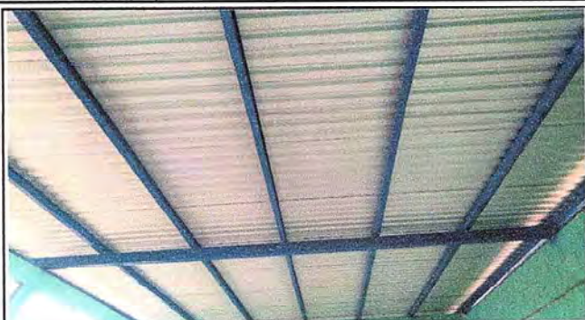
Se observa el cambio de laminas del techo del establecimiento.
