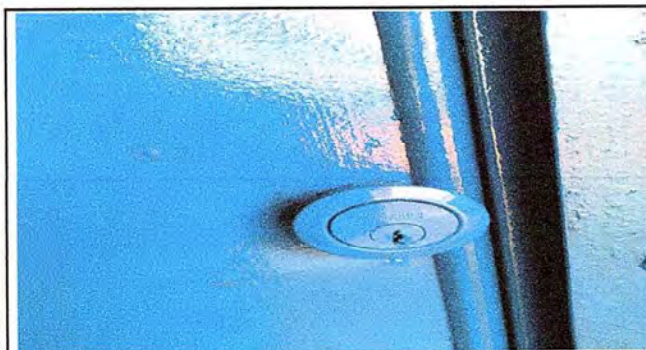
Se observa el cambio de chapas en las entradas de las aulas.
